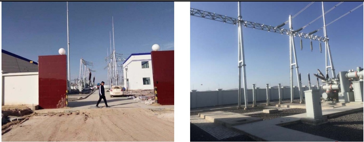
图3 王盘山 330kV 升压站间隔扩建工程现状
