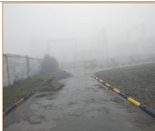
升压站场地硬化
