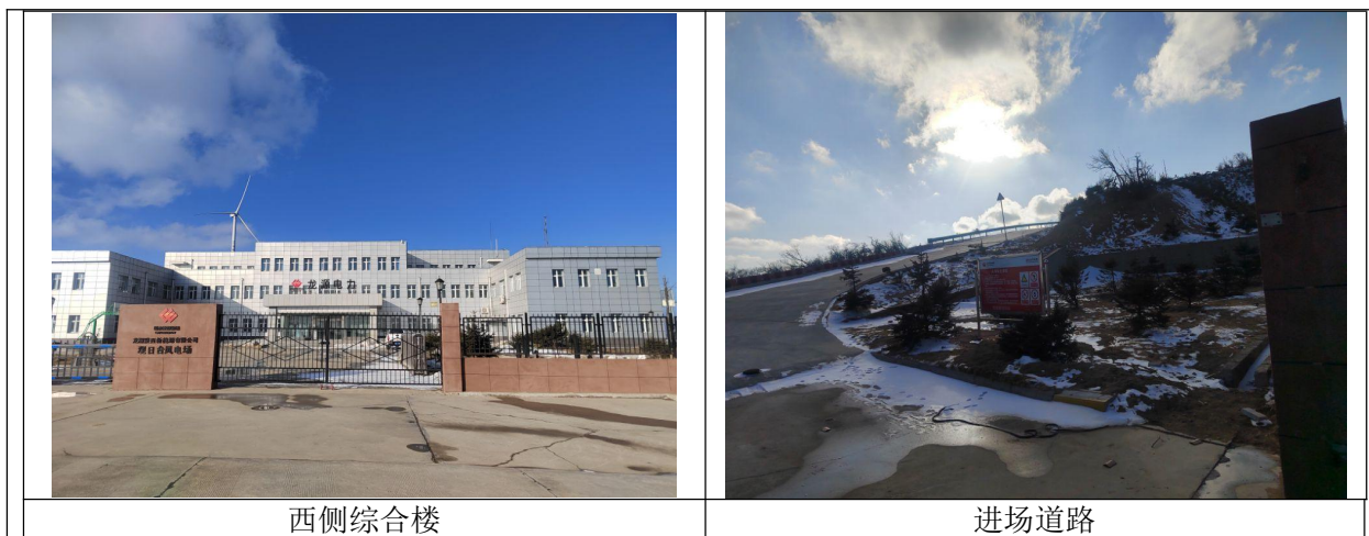
图4-2 项目建设现状图
