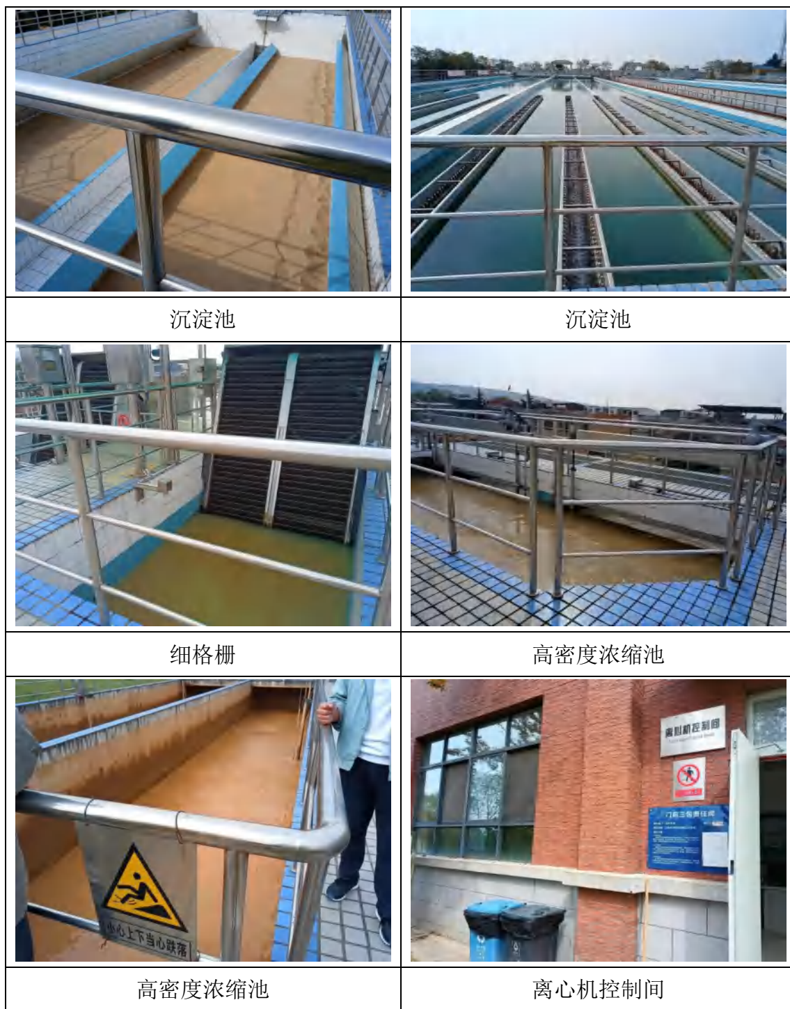
图2-2 净水厂厂区及净水车间现场照片
