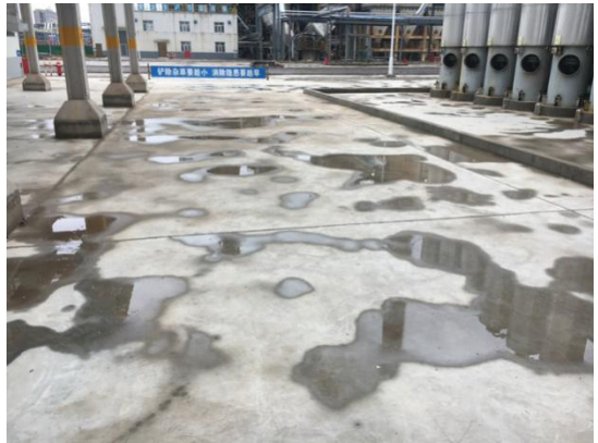
进场道路道路区
