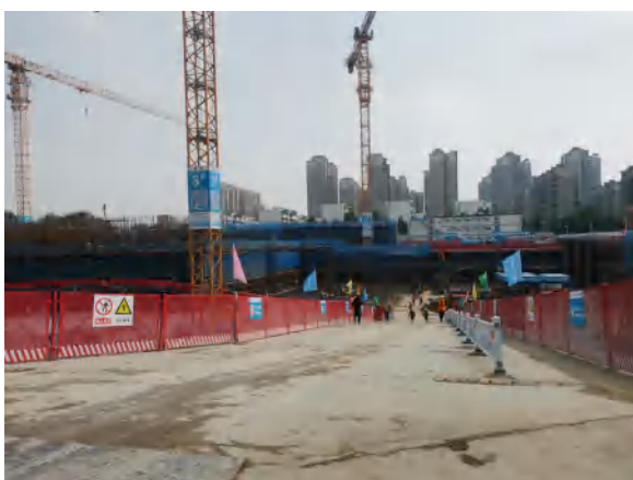
项目区内施工道路现状
