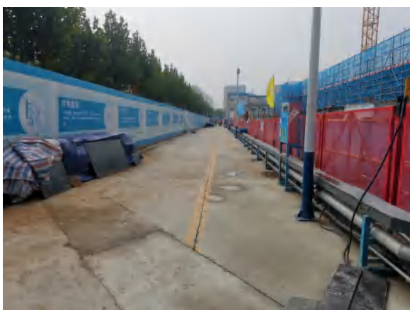
项目区施工道路现状
