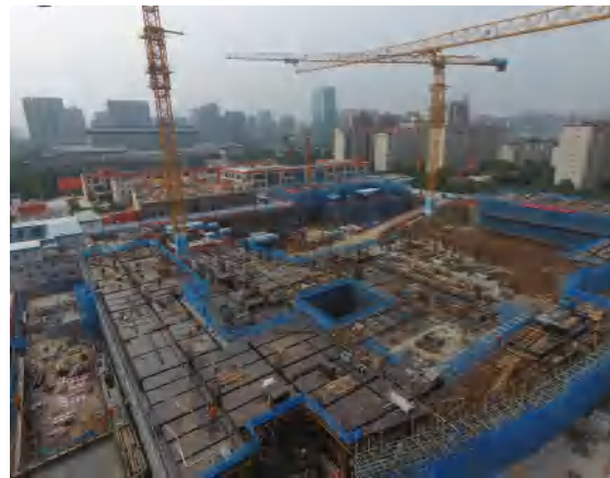
项目区主体工程现状
