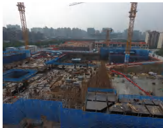
项目区主体工程现状
