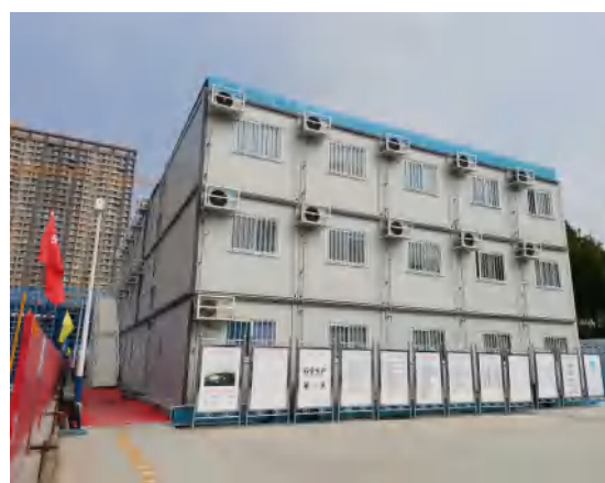
项目区施工临建现状
