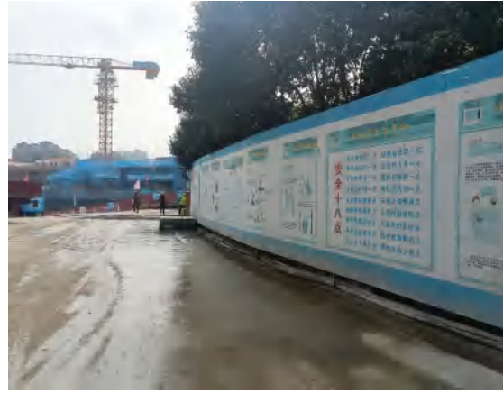
项目区场内硬化
