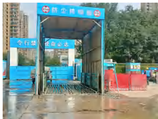
施工出入口洗车池
