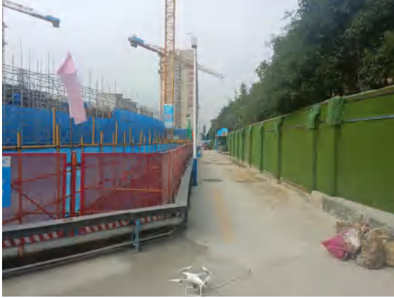
项目区场内硬化
