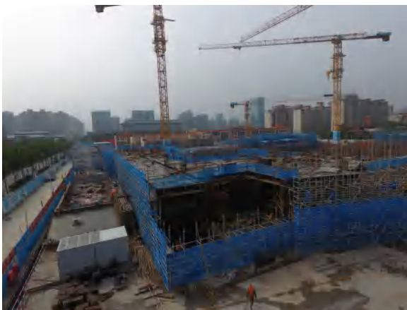
项目区主体工程现状
