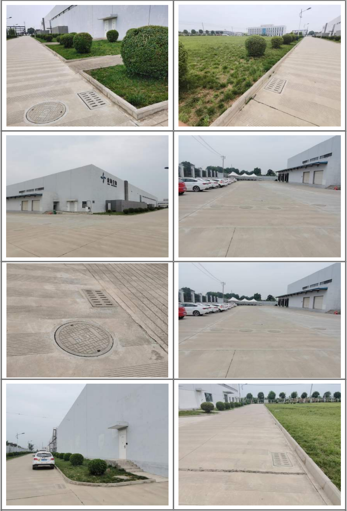
厂区内雨水口、雨水井
