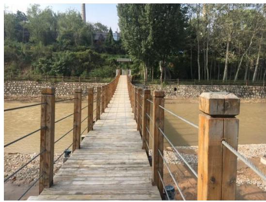
黄堡工业园区段吊桥 1
