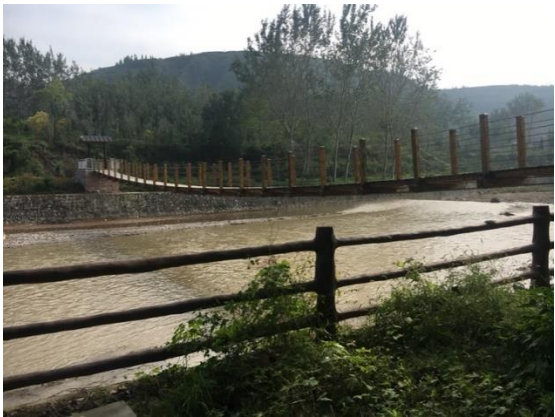
黄堡工业园区段吊桥 1
