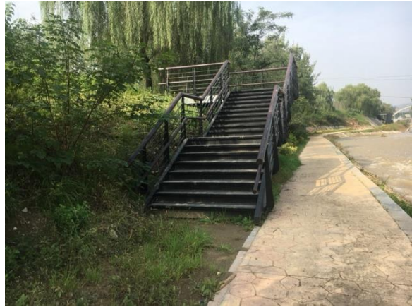
生态修复之宜居段钢楼梯
