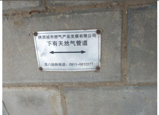
管线地面示警标识及抢险电话
