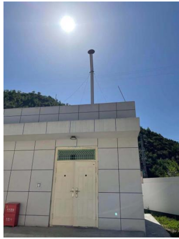
燃气锅炉排气筒
