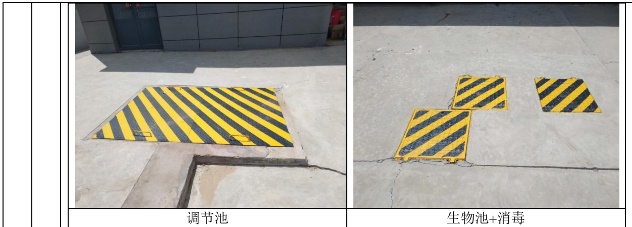
图7-4 运营期期废水处理措施（依托一期）
