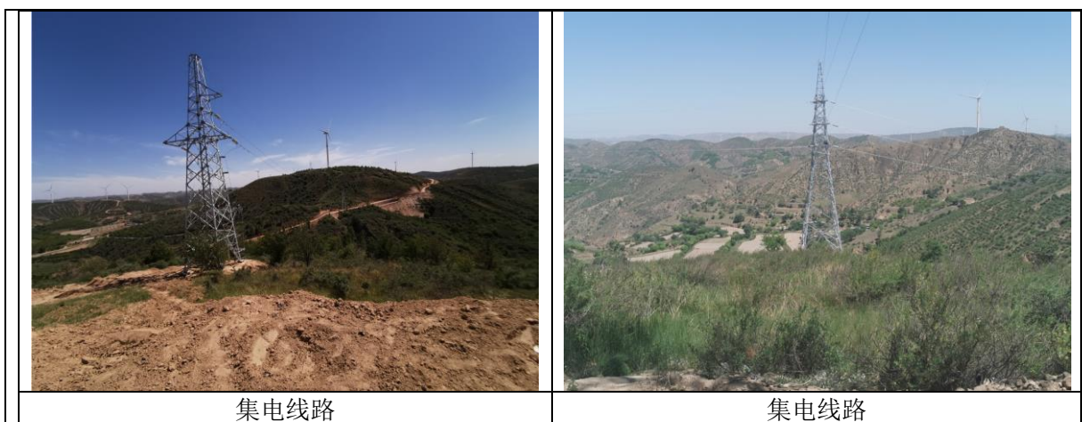
图4-2 项目建设现状图
