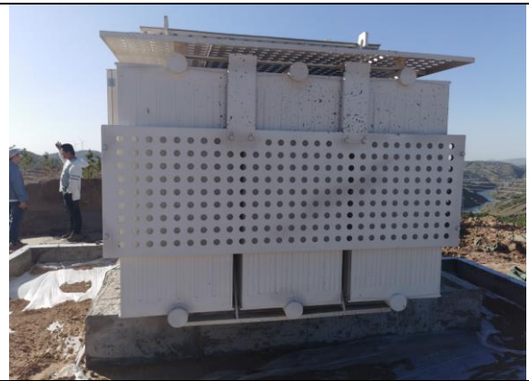
35kV 变压器
