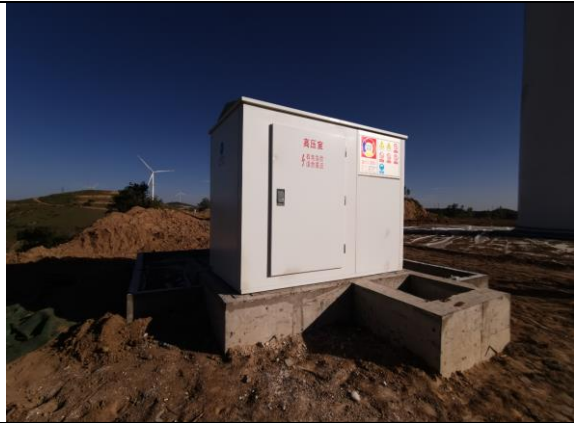
35kV 变压器
