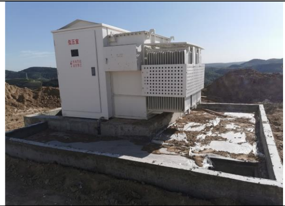
35kV 变压器
