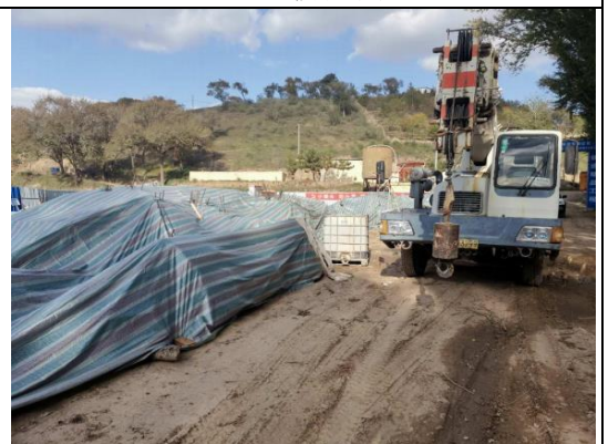
建筑材料遮盖
