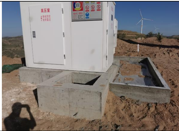
35kV 变压器
