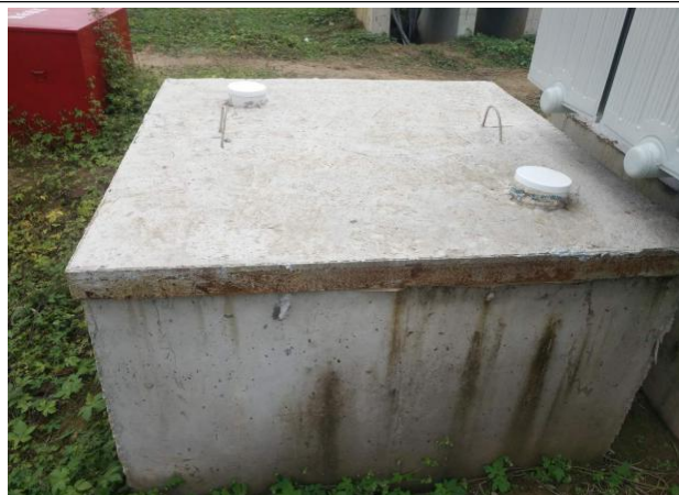
箱变事故油池
