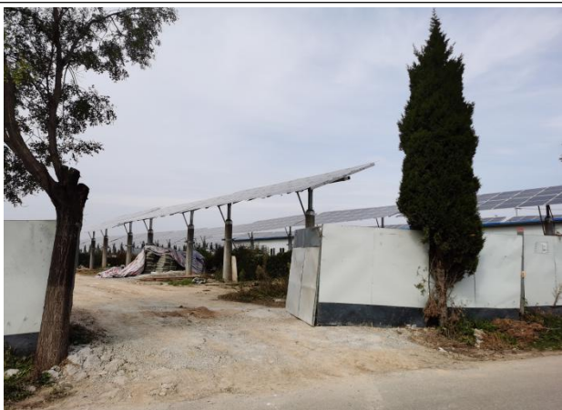
施工场地围挡
