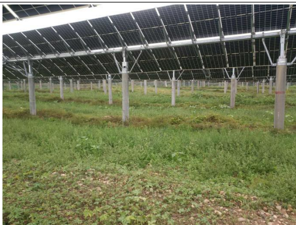
光伏板下植被恢复
