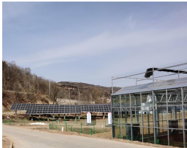
阳光棚与光伏板位置
