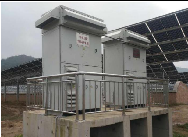
逆变器基础减震
