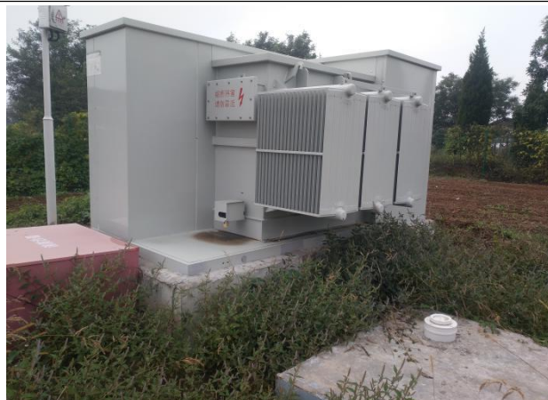
箱变基础减震
