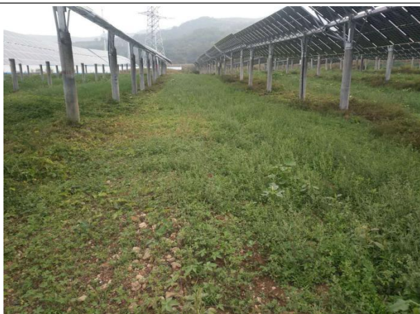
光伏板下植被恢复
