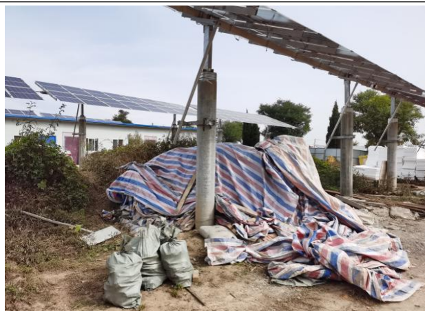
施工期物料苫盖
