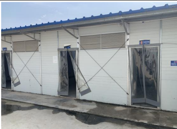
施工期生活区卫生间
