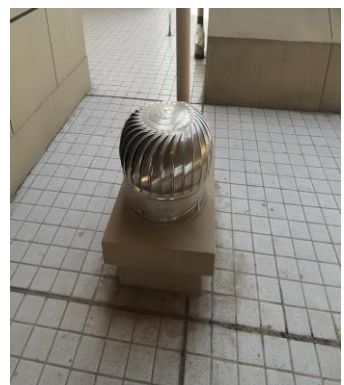
住宅楼楼顶排烟口
