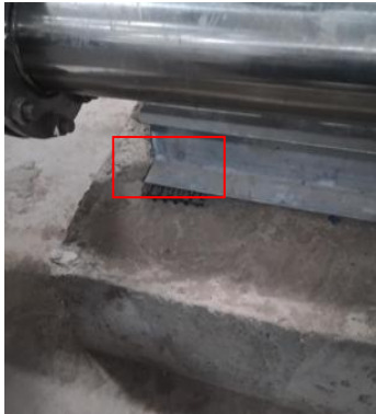
换热站设备的减震垫
