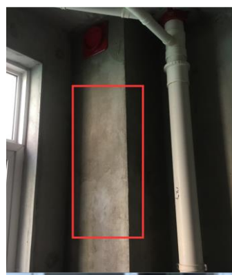
厨房油烟专用通道
