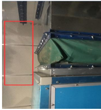
风机房的吸声墙
