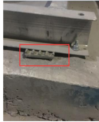
风机房风机的减震垫
