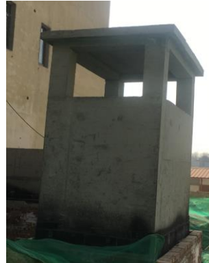
地下车库废气排放口
