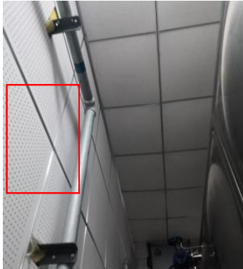
水泵房的吸声墙
