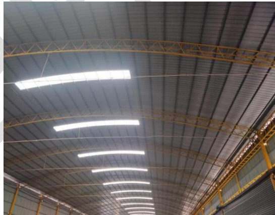
库房顶部喷淋装置 (白色水管)
