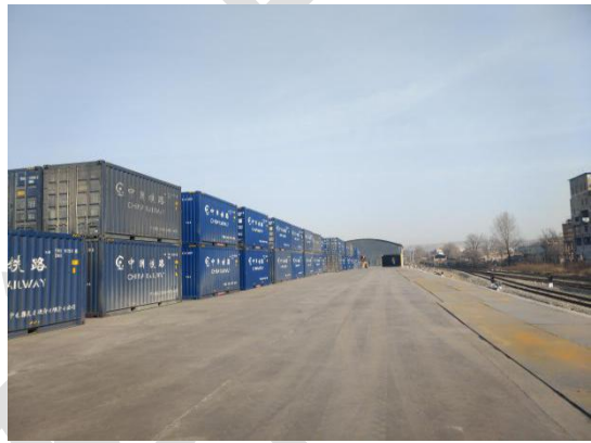
水泥硬化站台
