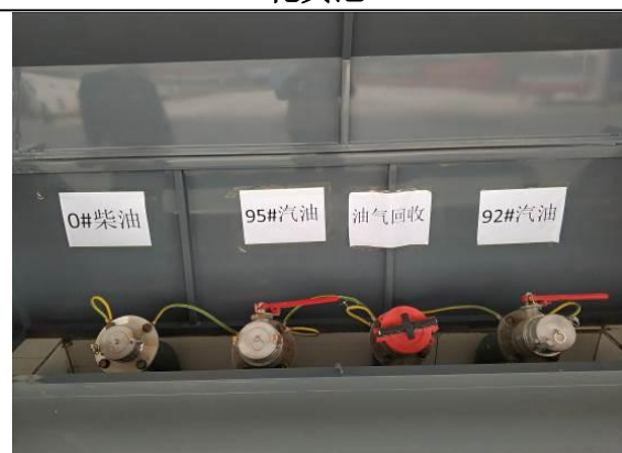
油气回收装置
