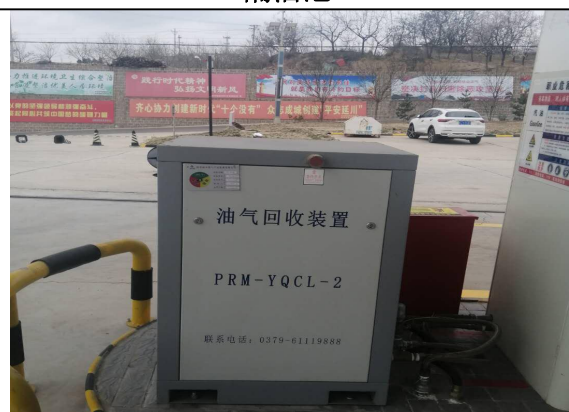
油气回收装置
