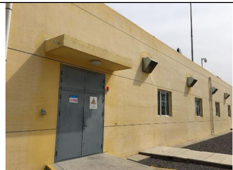
110kV 升压站 35kV 配电室
