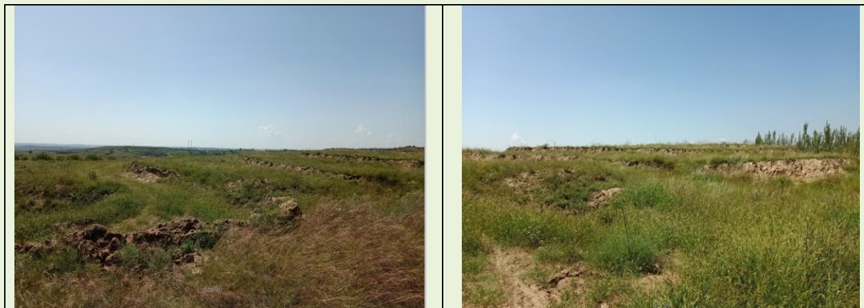
图 1-1 府谷宁源碛塬风电场及 110kV 升压站现状
