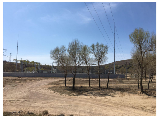
110kV 升压站北边空地
