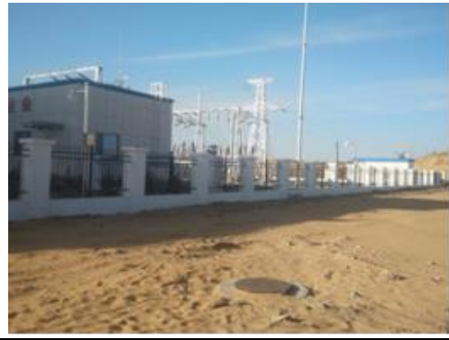
隔油池、化粪池
