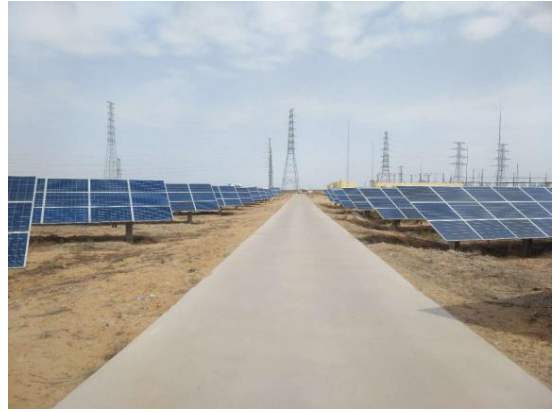
光伏区道路硬化
