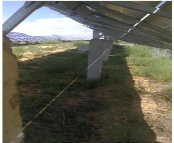
太阳光伏板下植被绿化
