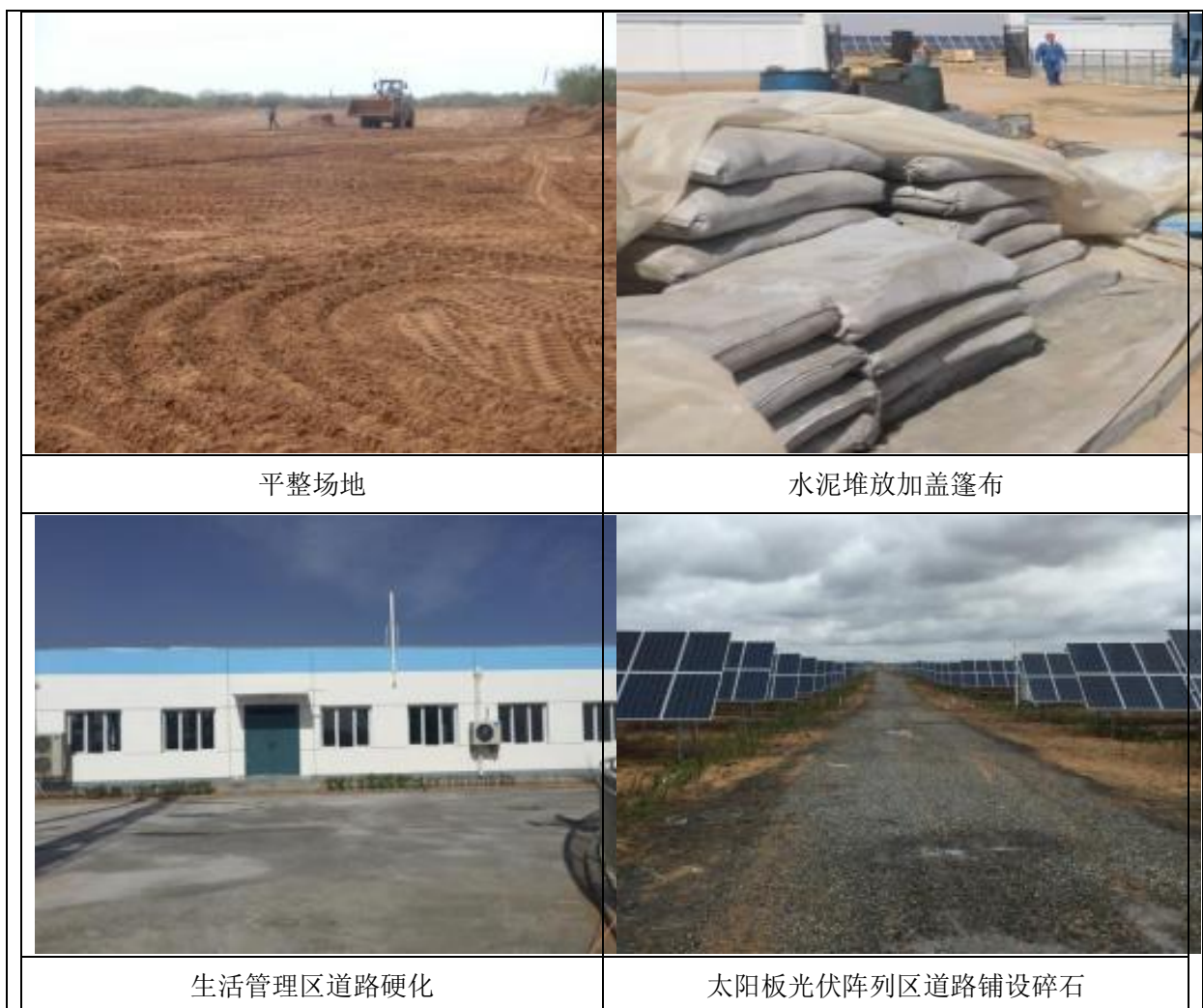
图 4-9 施工期大气污染控制措施照片
