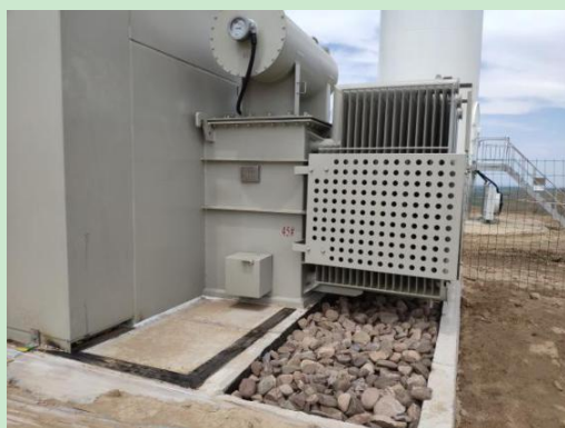
箱变事故油池（1）
