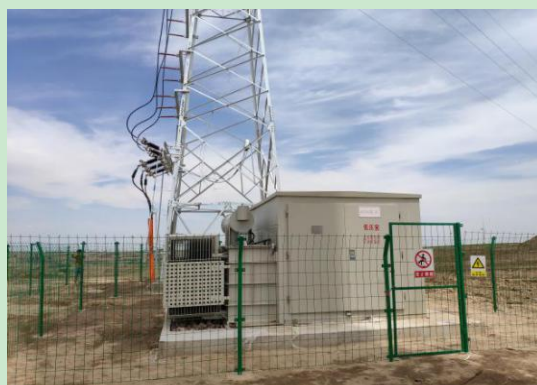
箱变事故油池（2）
