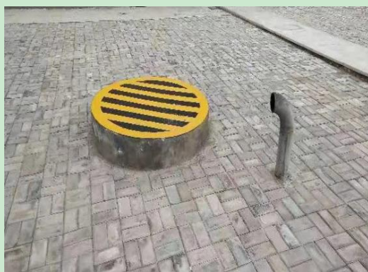
升压站事故油池
