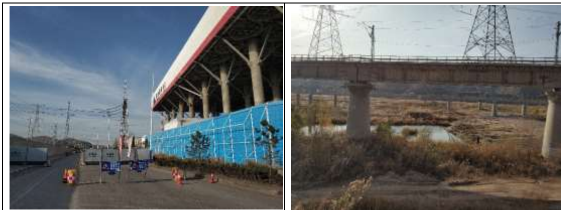
店塔电厂750kV升压站站外植被分布情况
