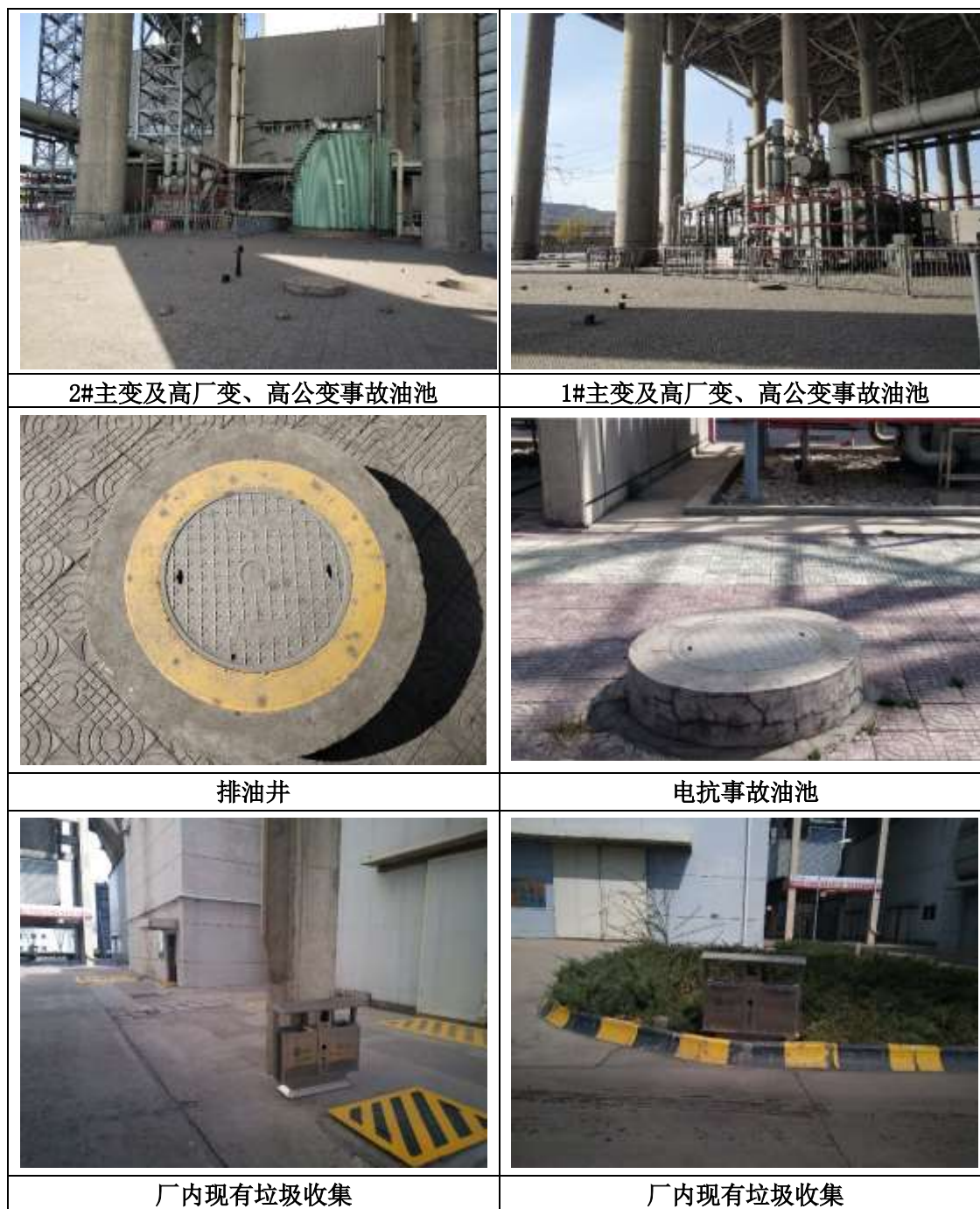
图 10.3-1 升压站内固废处理设施
