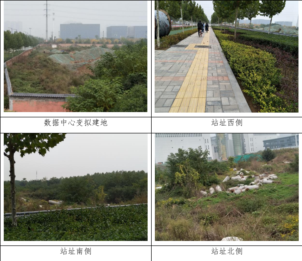
图 1 本项目数据中心 110kV 变站址及周围概况
