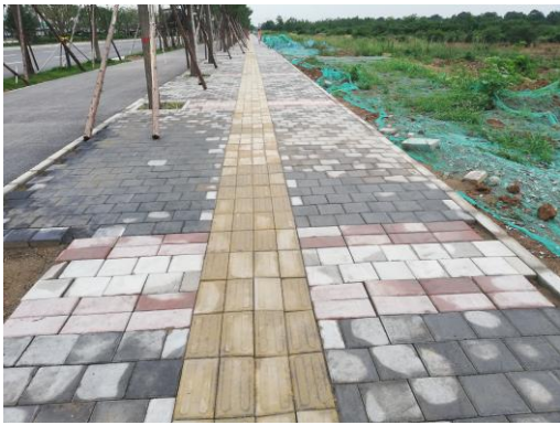
电缆敷设现状 1
