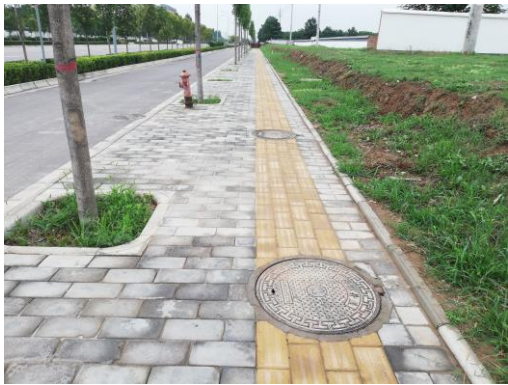
电缆敷设现状 3
