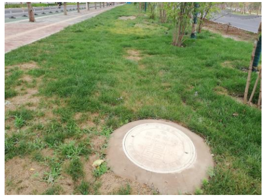
电缆敷设现状 2
