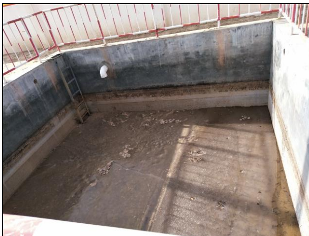
图 7-4 杏二转站场雨水蒸发池
