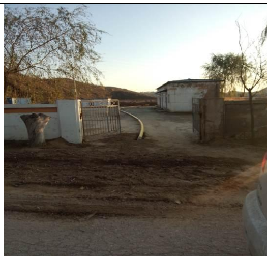
进场管线回填及平整
