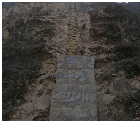
陡坡段的管线护坡及土袋回填
