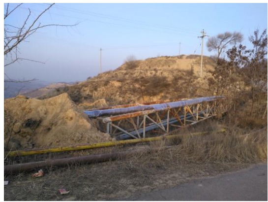
管线跨沟及沟头生态恢复
