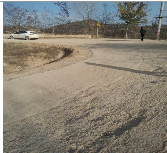
道路一侧的管线敷设及生态恢复
