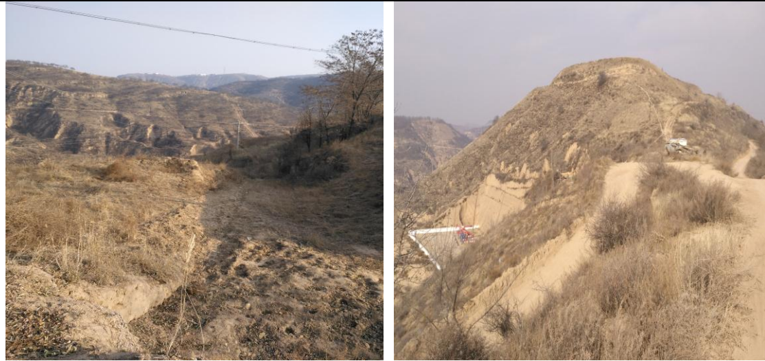
管线土坡埋设段回填平整及生态恢复
