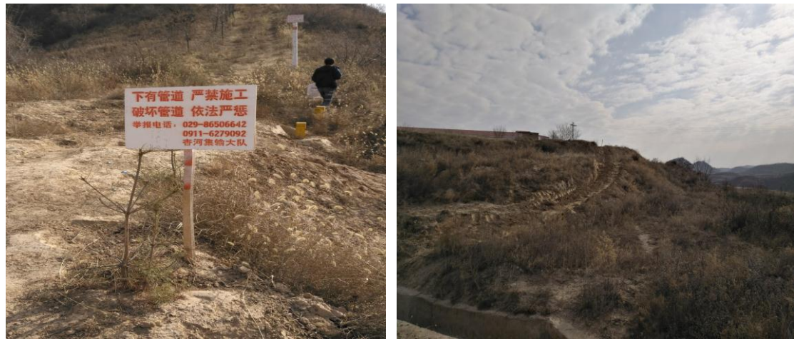
管线土坡埋设段回填平整及生态恢复
