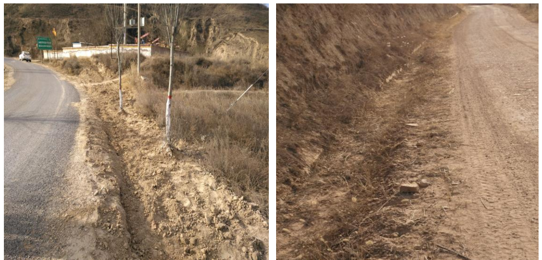
道路一侧管线埋设段回填平整及生态恢复
