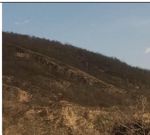
缓土坡段的挖土回填及恢复
