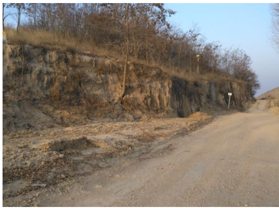
管线沿道路一侧埋设回填及生态恢复
