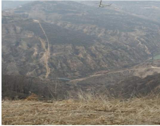
管线跨沟及土坡埋设回填
