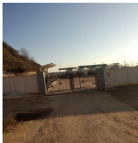
贺一转井场路面恢复
