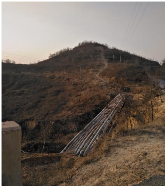
管线跨沟及土坡埋设段生态恢复
