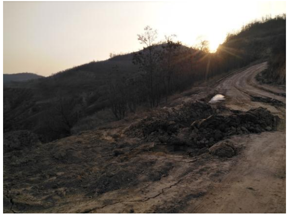
管线沿道路一侧埋设回填及平整
