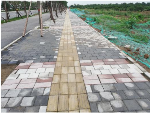
电缆敷设现状 1
