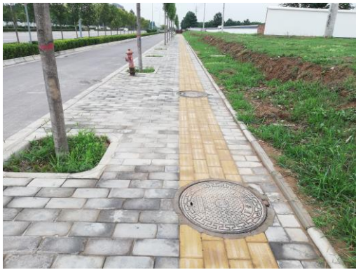
电缆敷设现状 3
