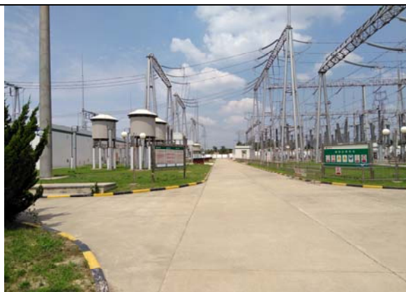
东塬变进场道路
