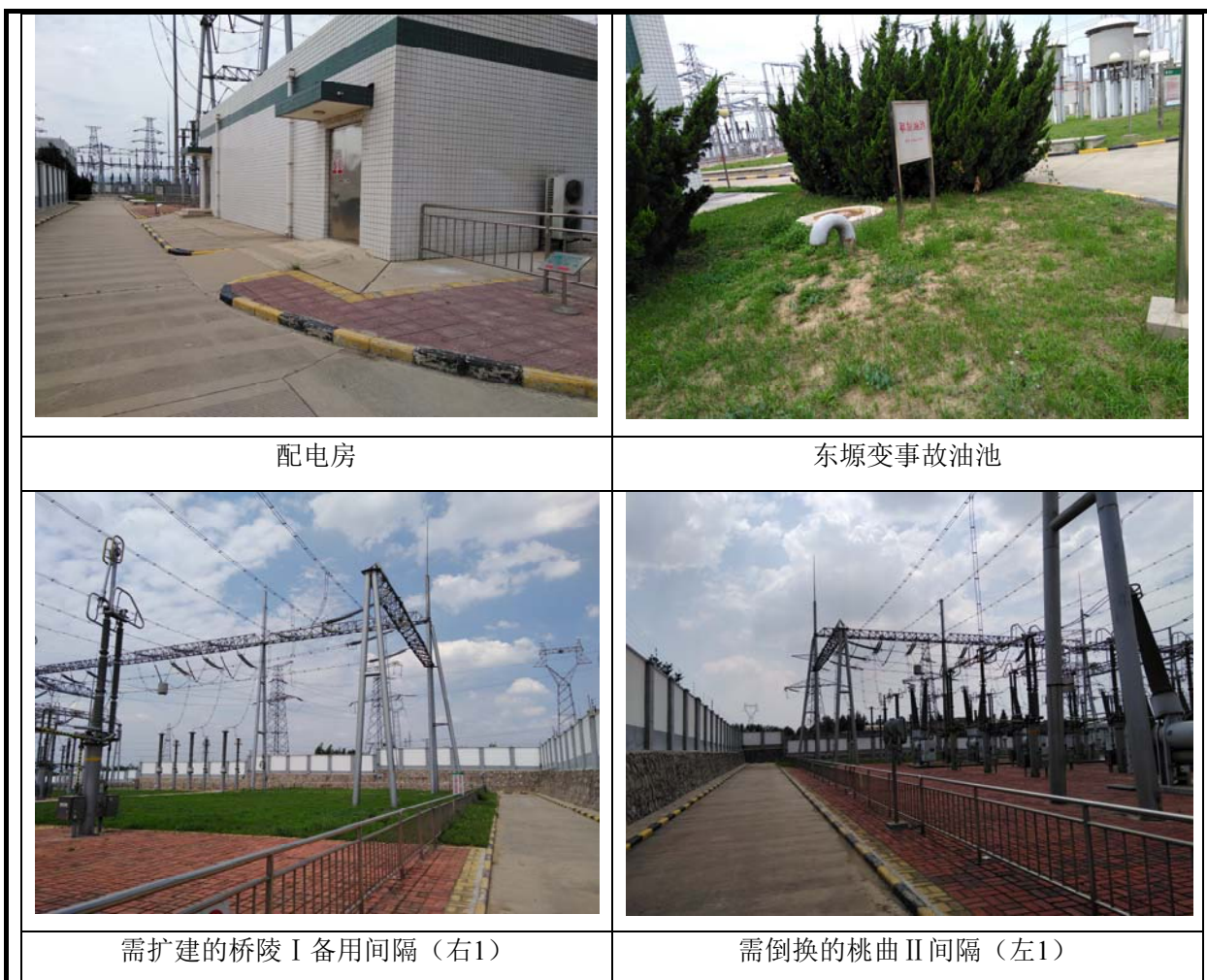
图 9 东源变建设现状
