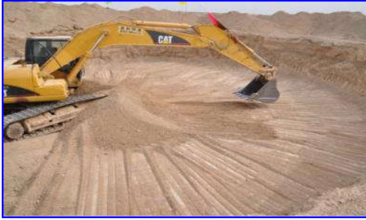
风机基础开挖图示
