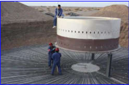
基础环预埋安装图示
