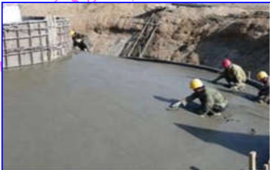
混凝土浇筑工程图示
