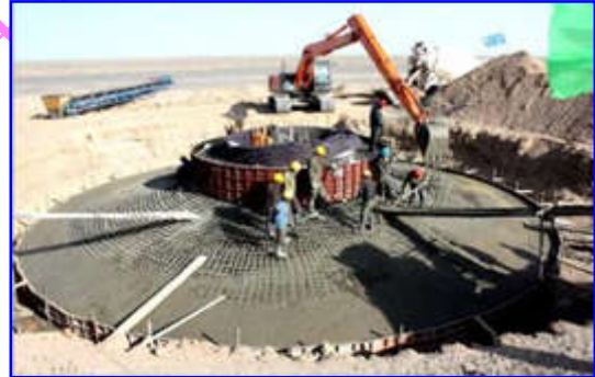
混凝土浇筑工程图示
