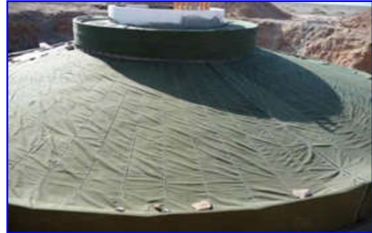
混凝土养护图示
