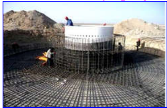
基础环预埋安装图示
