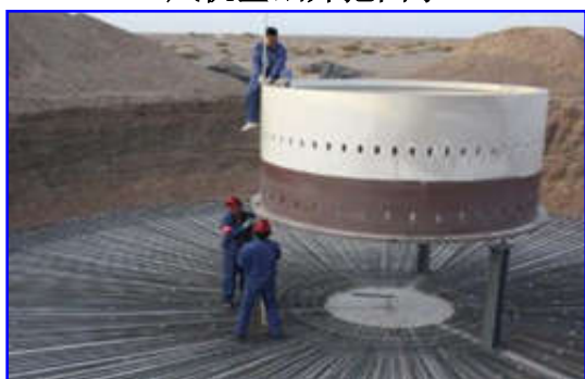
基础环预埋安装图示
