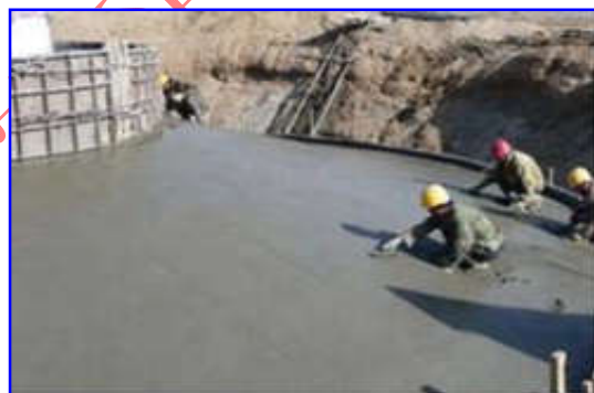
混凝土浇筑工程图示
