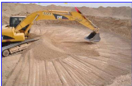
风机基础开挖图示
