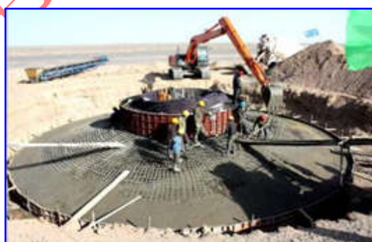
混凝土浇筑工程图示
