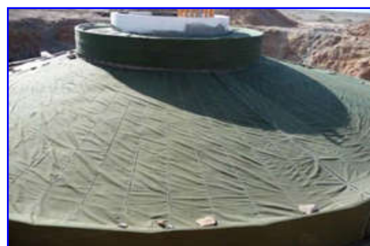
混凝土养护图示
