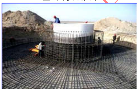
基础环预埋安装图示
